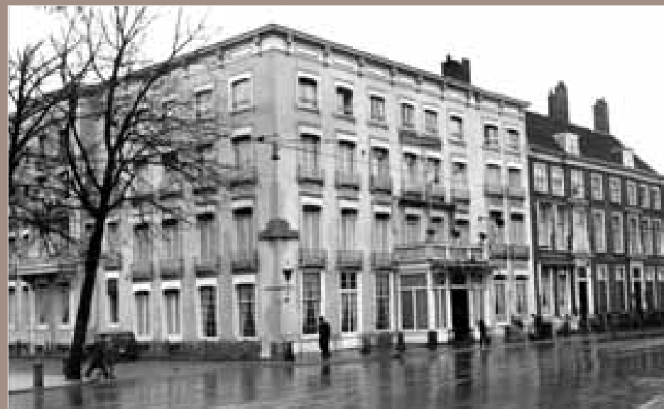
Verbouwd en opgehoogd
